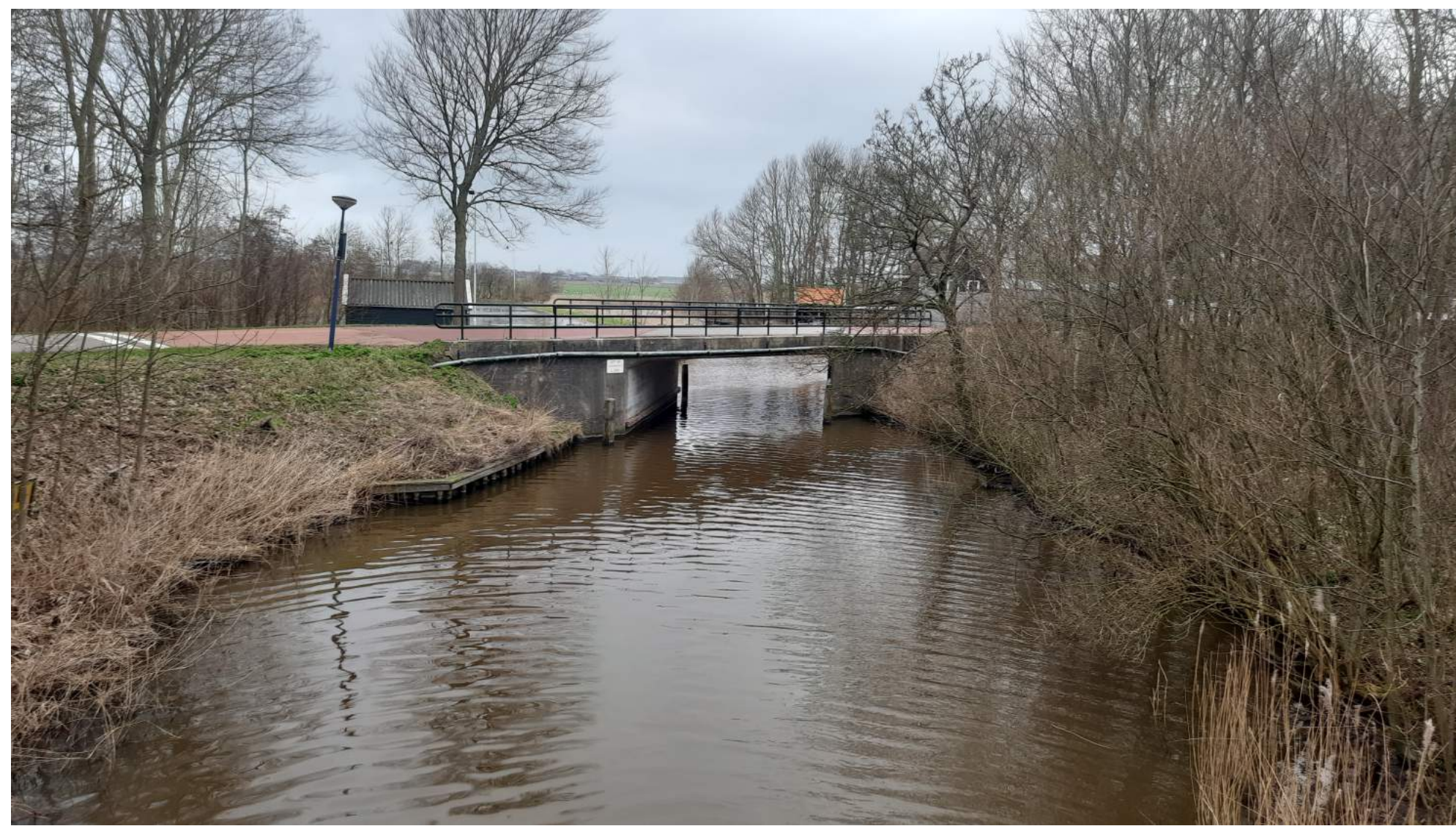
Foto bestaande situatie
